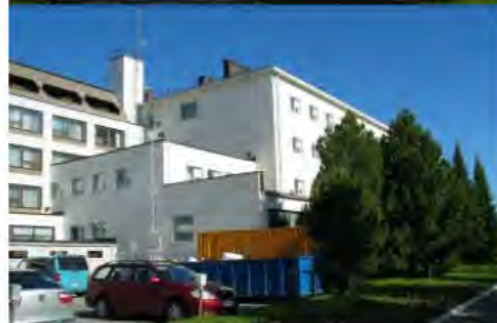
Ounaskosken puoleinen julkisivu laajennuksineen.
